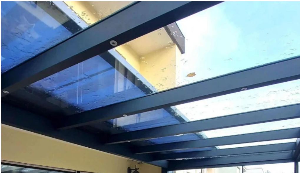
Mai bauschlosserei stahlbau kgmetallbau bauunternehmen
