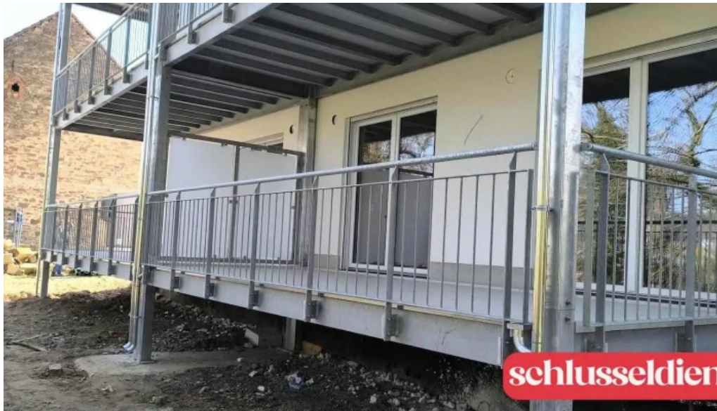
Mai bauschlosserei stahlbau kg metallbau graben neudorf
