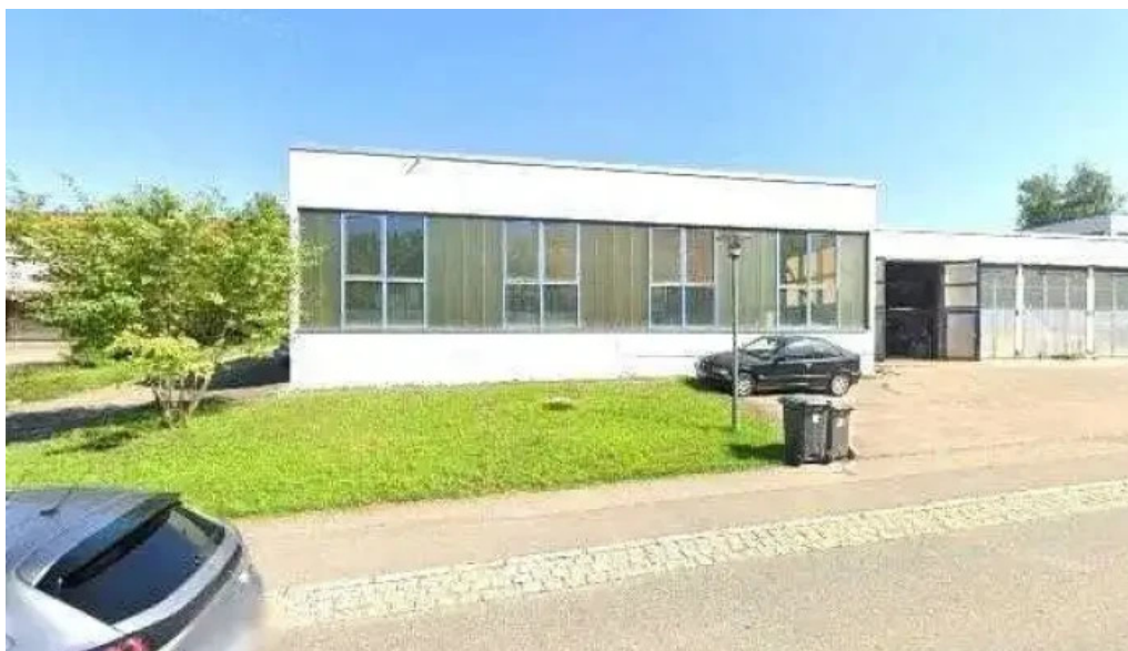
Huss stahl und metallbau gmbh alle
