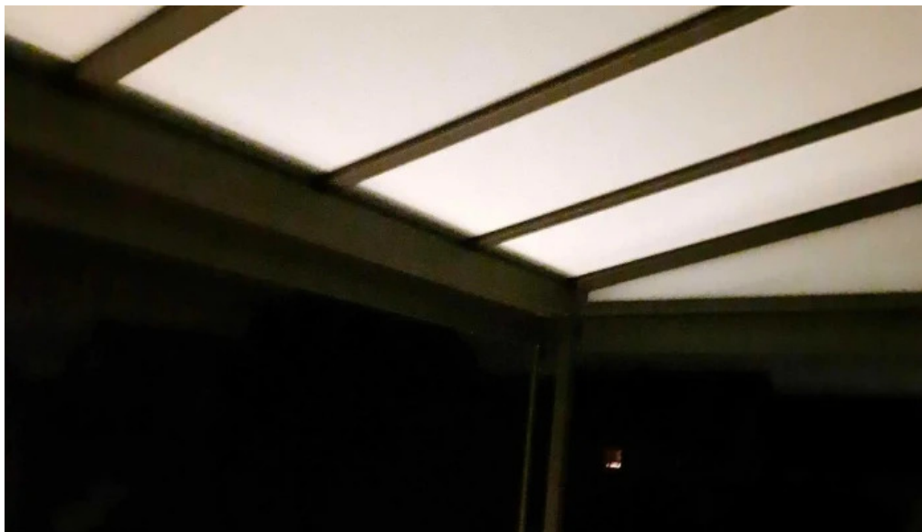
Drittenthaler stahlbau gmbh neu ulm
