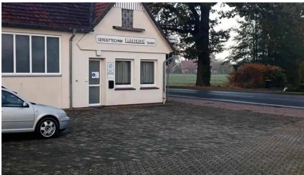
Gerusttechnik badbergen gmbh alle
