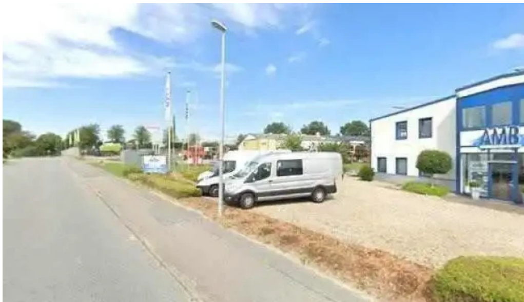
Amb Anlagen und Metallbau GmbH alle
