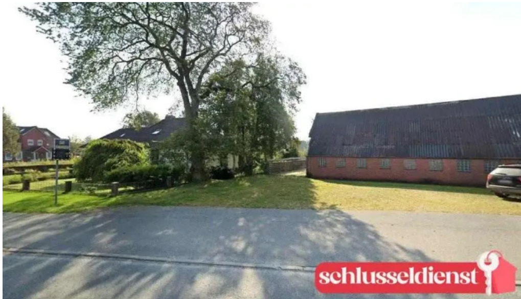
Stahlbau callsen gmbh achtrup
