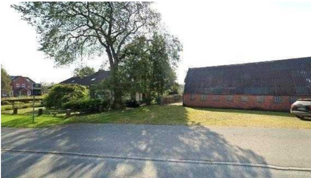
Stahlbau callsen gmbh alle
