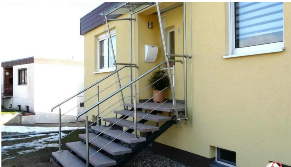
B s metall und solarbau gbr vom inhaber
