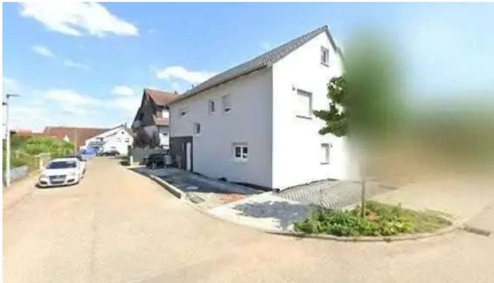
Till metall schlosserei und metallbau street view 360deg fotos
