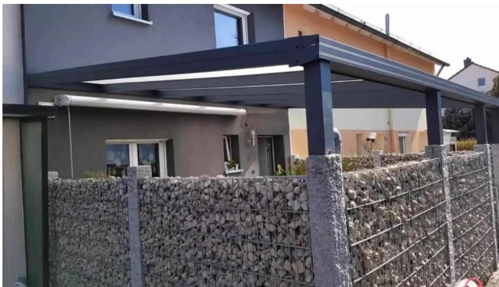
Metallbau rosenfelder gmbh aussenbereich
