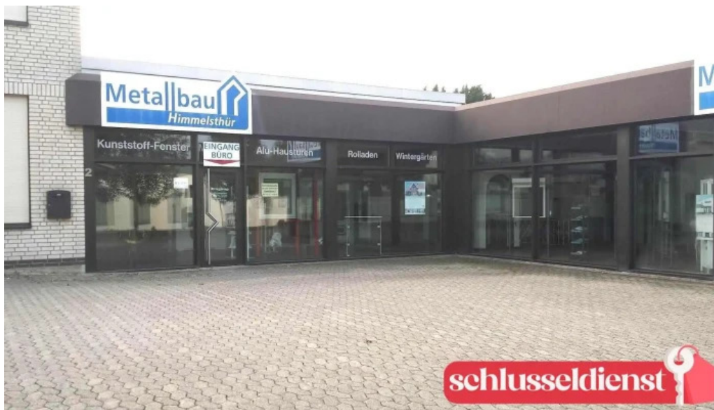
Metallbau himmelsthur bauelemente gmbh hildesheim
