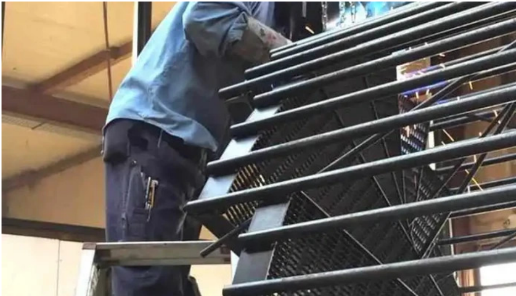
Bernd a bremer stahl und metallbau gmbh co kg stahlbau alle
