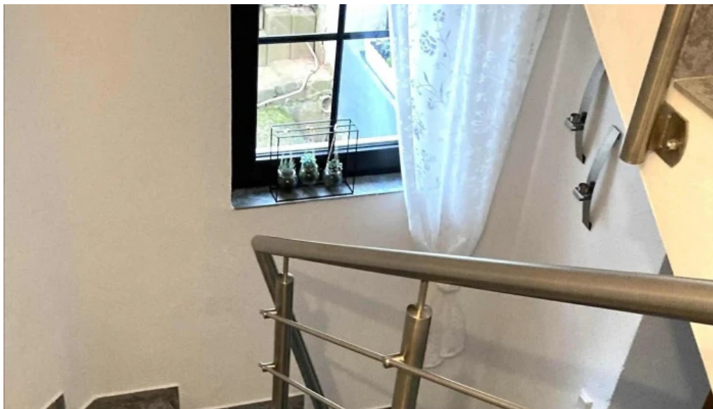
Eydt metallbau und maschinenbau gmbh standort
