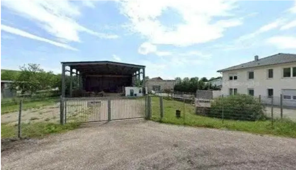
Luft metallbau street view 360deg fotos
