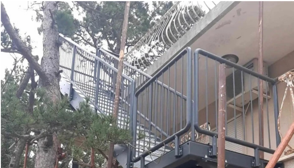
Adrotec gmbh schlosserei metallbau montage wo
