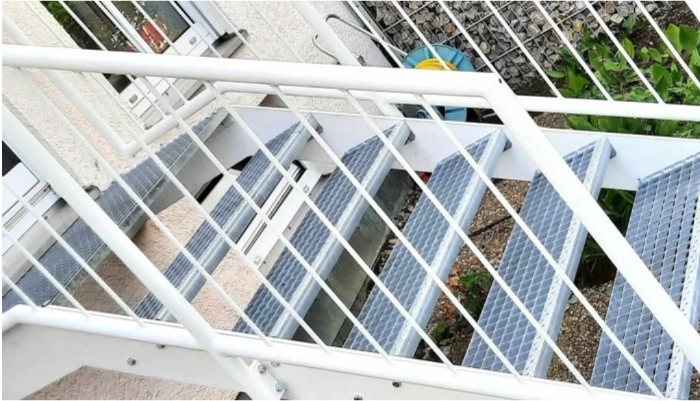
Plessing gmbh schlosserei und stahlbau fotos
