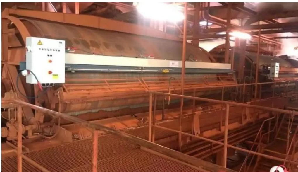
Mb klintworth maschinen und metallbau innenansichten
