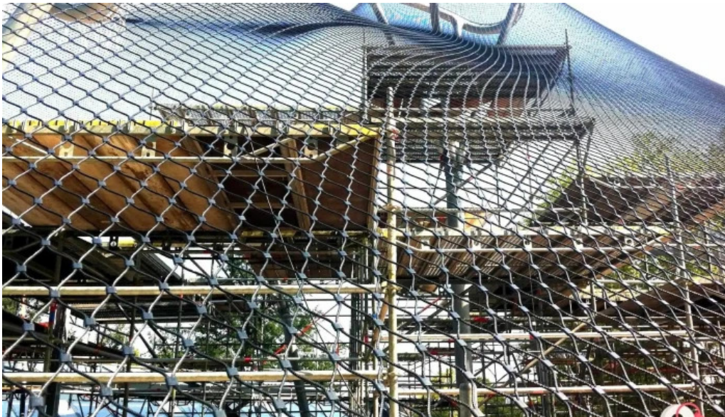
Roleff gmbh co kg stahlbau schlosserei niederlassung ludwigsburg alle
