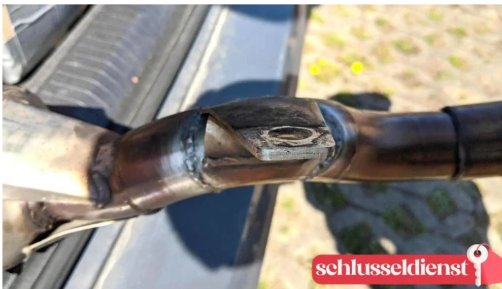
Robert jablonski bauschlosserei und schmiede neueste
