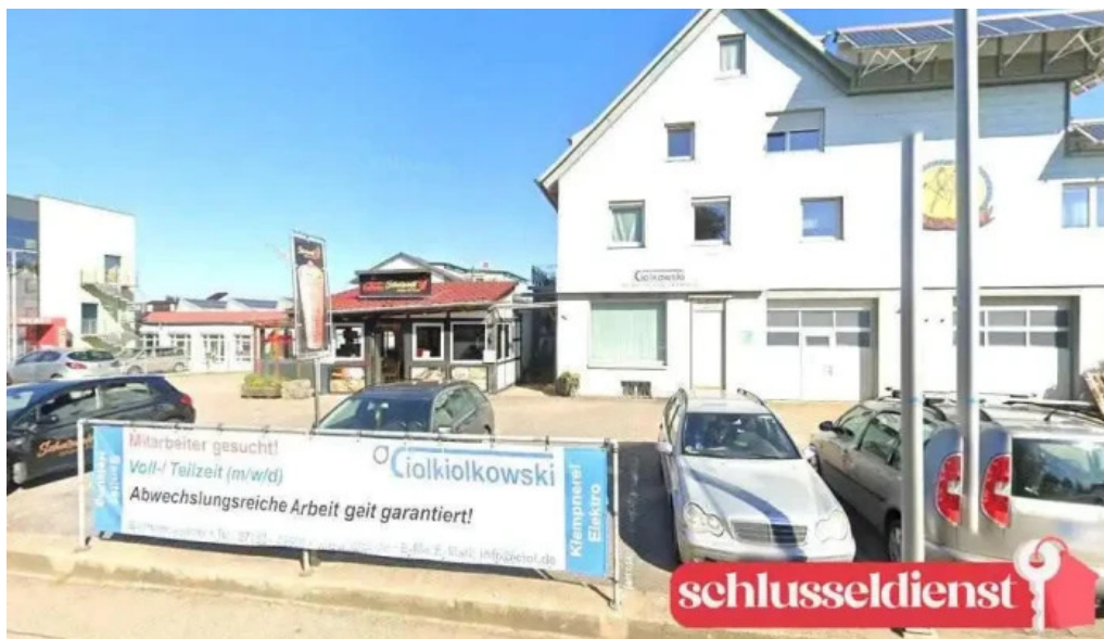
Ciolkowski gmbh sanitar heizung klempnerei baltmannsweiler
