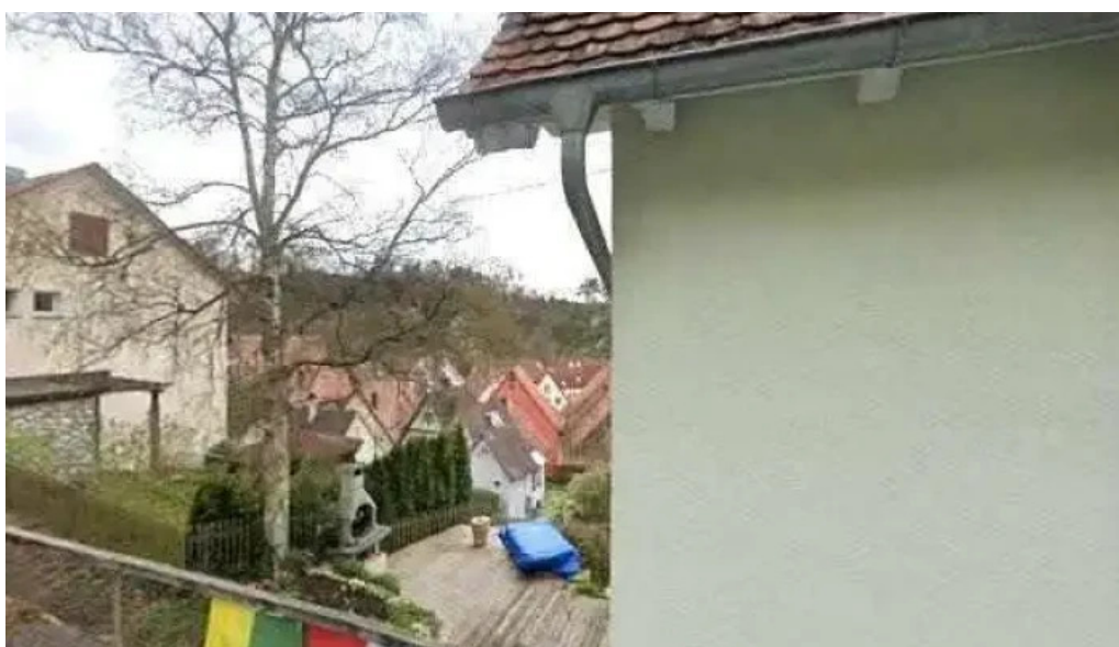
Peterskapelle street view 360deg fotos
