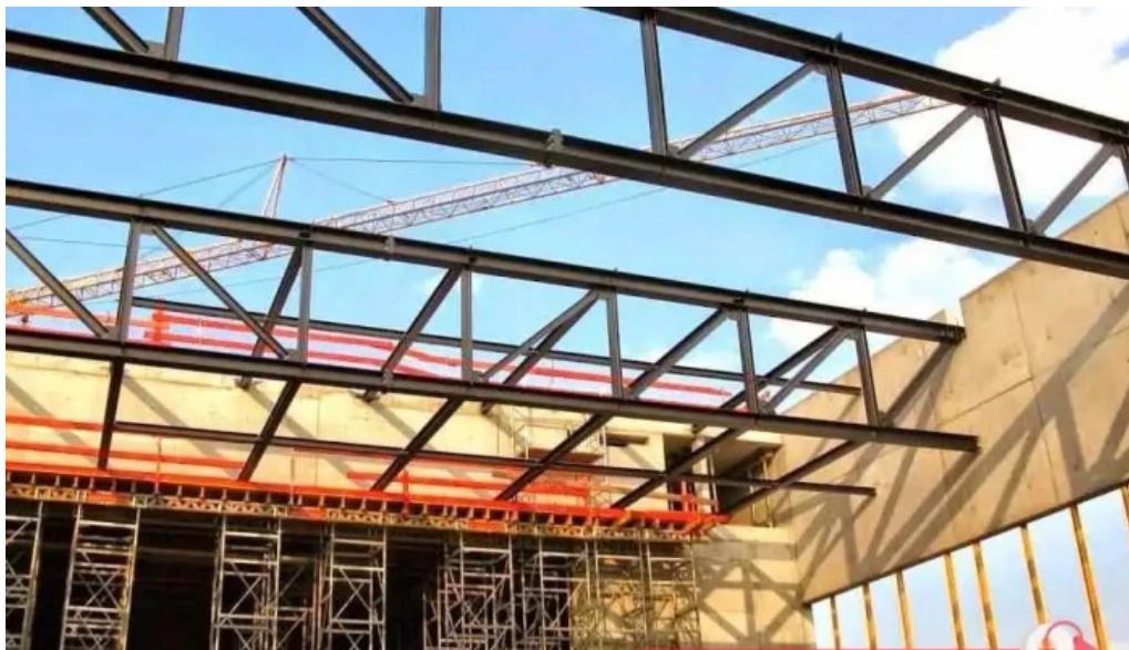
Huber stahlbau gmbh kirchberg an der jagst
