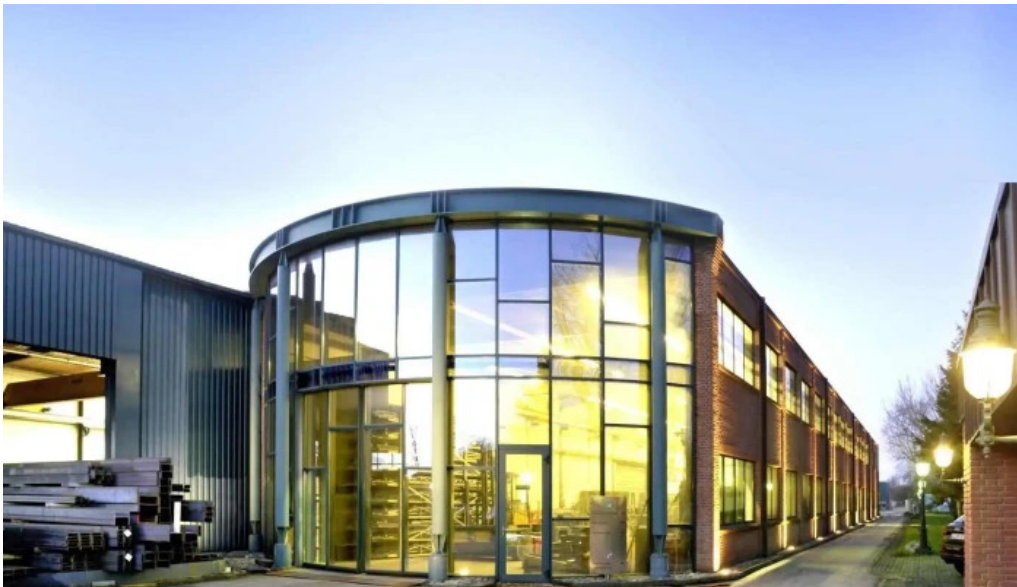
Butzkies stahlbau gmbh vom inhaber
