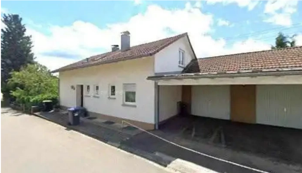
Stahlbau riedinger gmbh schlossereistahlbaumetallbau street view 360deg fotos
