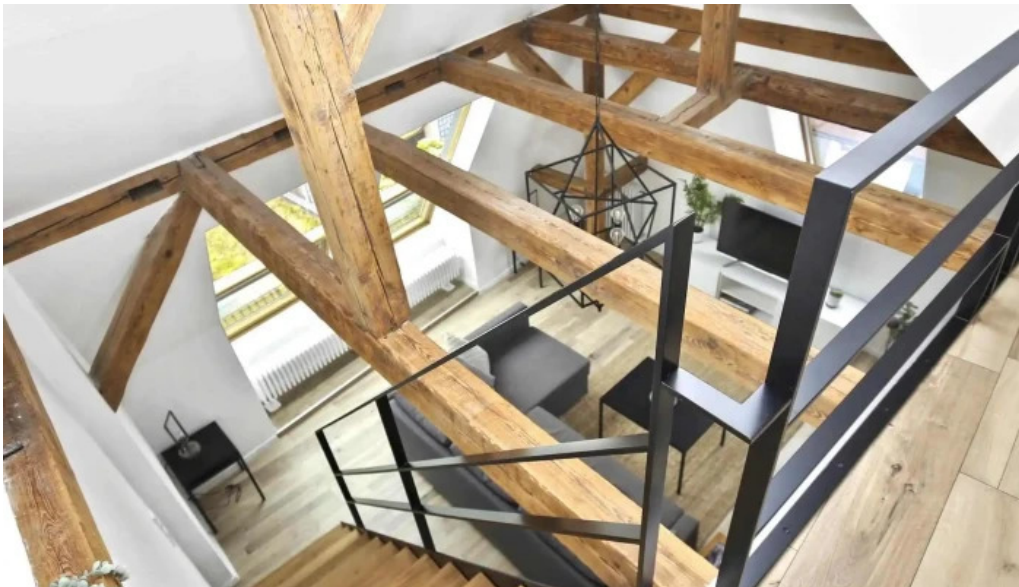
Treppenbau kreuzberger werk fotos
